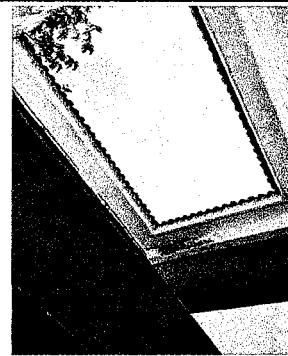
SUMINISTRO E INSTALACIÓN DE LÁMINA
