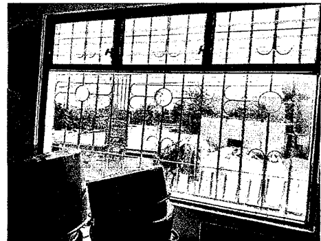
SUSTITUCIÓN DE VENTANAS FIJAS POR CORREDIZAS DE PVC
