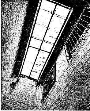
SUSTITUCIÓN DE ESTRUCTURA DE METAL POR METAL
